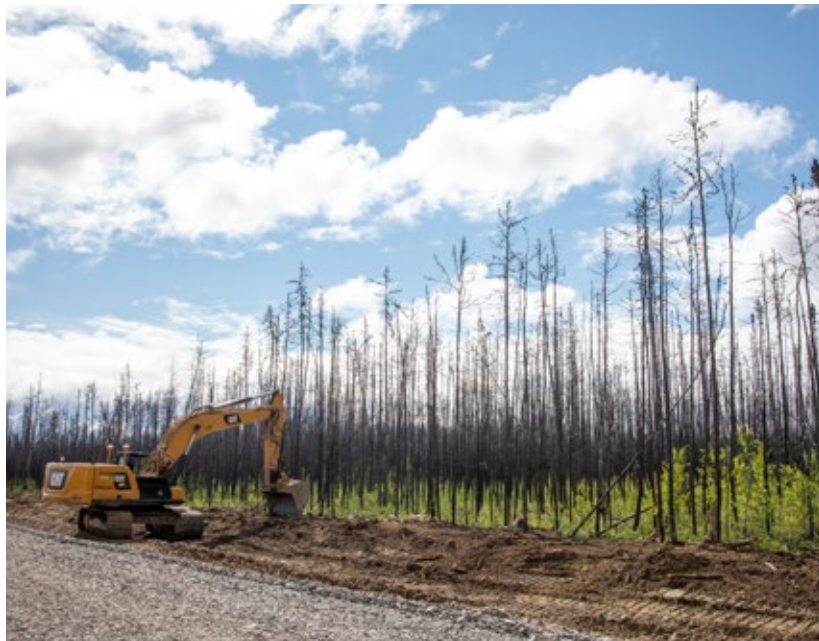
Ditch excavation for the Tłı̨chų Highway
