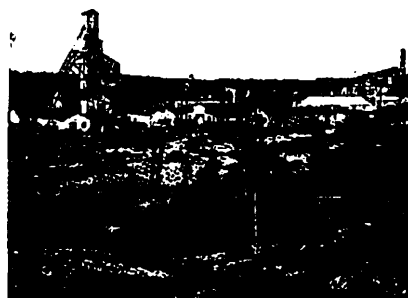
Installations d'exploitation modernes - mine d'or de la Giant Yellowknife
