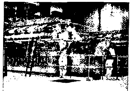
Génératrice diesel de 5,150 kW du type Mirrless, à Whitehorse (Yukon)
