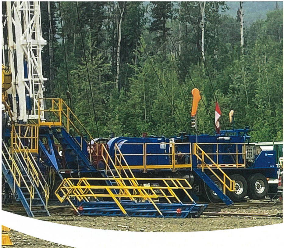
Plateforme de maintenance, puits Liard P-16, Liard West Field, juillet 2023. (BOROPG)
